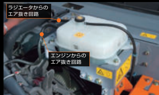
エキスパンションタンク
