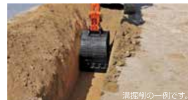
溝掘削の一例です。
